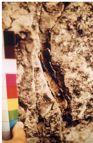
Fig.1 ACUSA C.7 Restos de argamasa aplicados en algunas grietas del techo de la cueva. En ellas se conservan las improntas dejadas por las yemas de los dedos al aplicar esta pasta.
