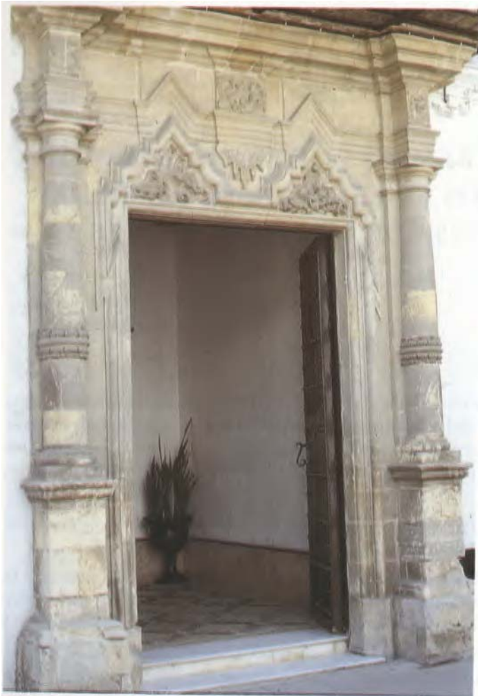
Fachada de una casa de familia de comerciantes sanluqueños del siglo XVII. (Reformada en el XVIII)
